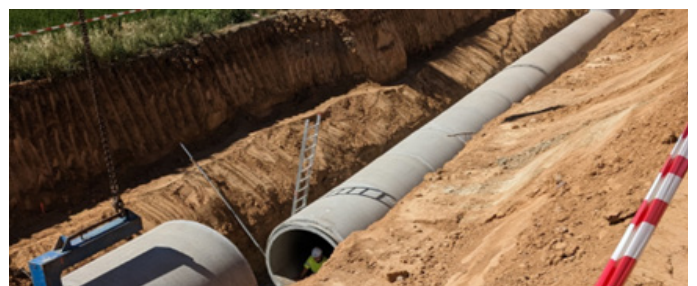
Elementos prefabricados para conducciones de saneamiento de secciones mixtas desplegados en la obra de Saneamiento y Depuración en Montijo-Puebla de la Calzada (Badajoz)
